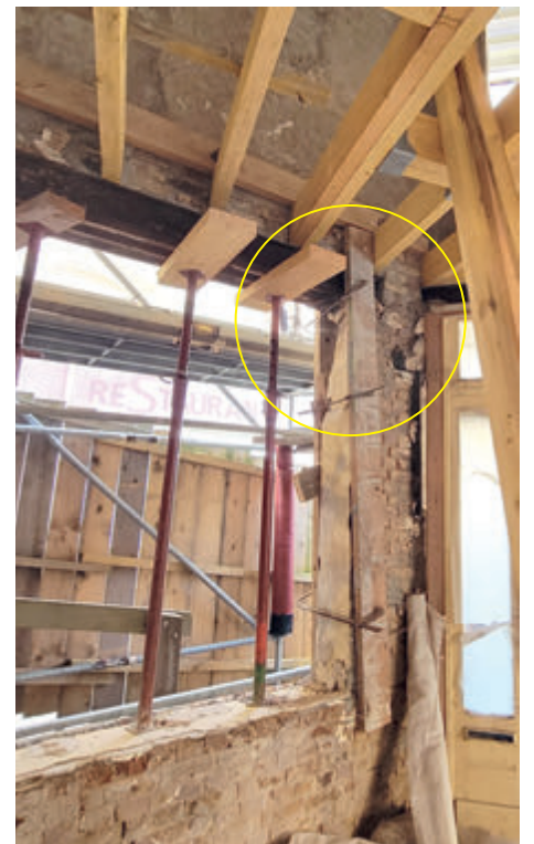
A gauche, le travail de charpente pour soutenir les planchers en arrière, et le décaissement des fondations du sous-sol pour une meilleure hauteur de plafond. Ci-dessus, les piliers de soutien de l'angle en bas de la pente Maurice Holleville sont très fragiles...
