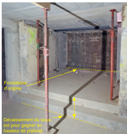
A gauche, le travail de charpente pour soutenir les planchers en arrière, et le décaissement des fondations du sous-sol pour une meilleure hauteur de plafond. Ci-dessus, les piliers de soutien de l'angle en bas de la pente Maurice Holleville sont très fragiles...
