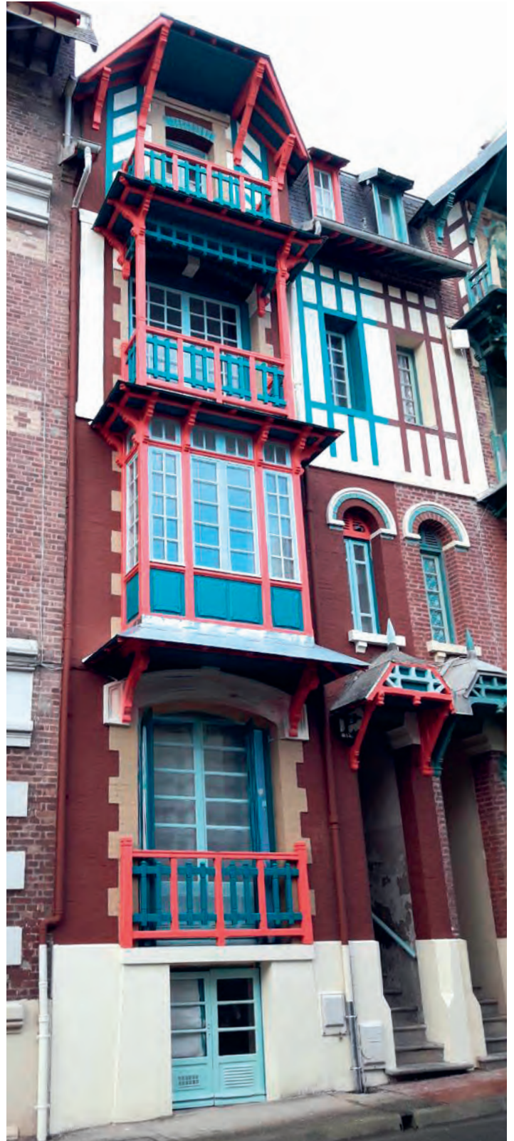
▲ 10 Rue Faidherbe. Autre exemple de villa balnéaire symétriquement opposée, cette voisine de la fameuse "Villa Parisienne" qui méritait bien d'être restaurée dans une belle alternance de tons contemporains originaux, révélant ainsi son potentiel. Notons le balcon sous toiture du dernier étage, original...
