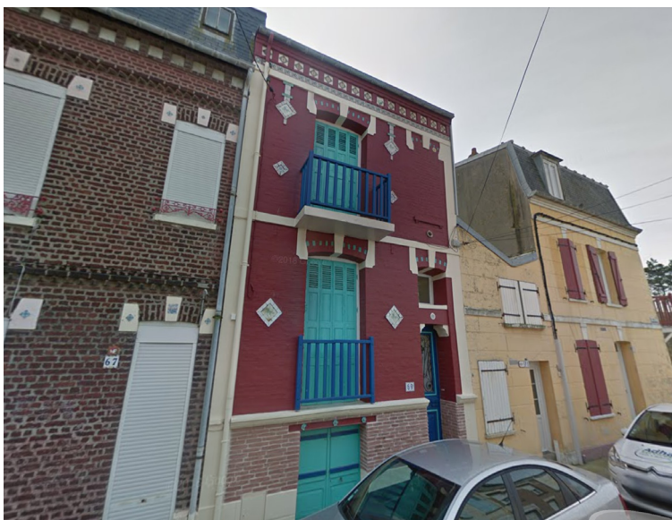
69 rue de Charlemagne
