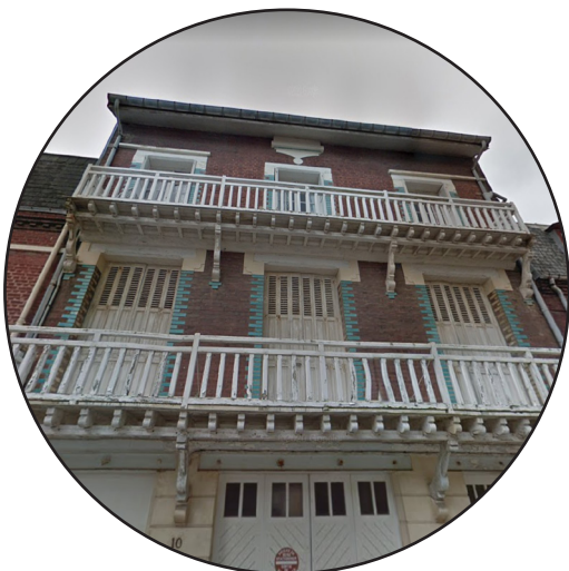
Immeuble collectif imitant la villa balnéaire
