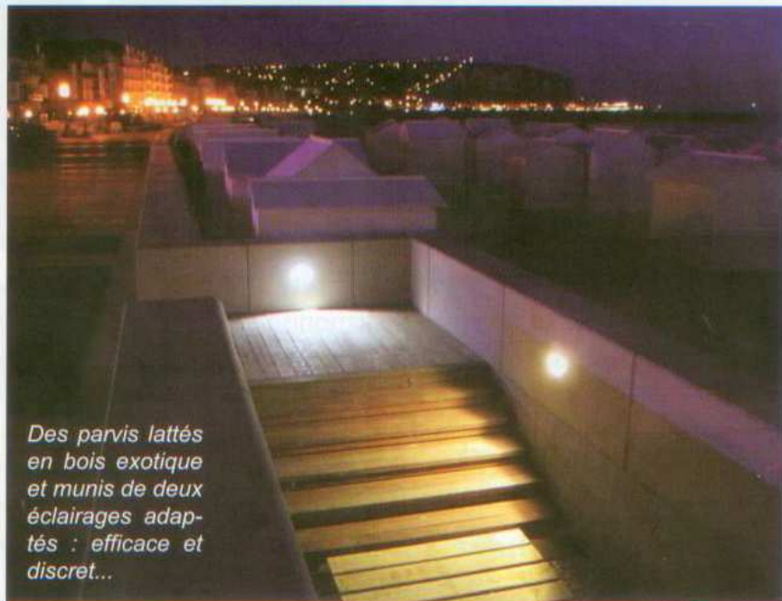
Ci-dessus, un aspect visuel d'un des parvis achevés côté falaise, avec les parapets du mur chasse mer, les escaliers en bois exotique et leur éclairage spécifique, orienté vers le bas afin de ne pas éblouir. Les tons clairs des différents matériaux sont bien harmonisés entre eux et s'intègrent parfaitement à l'esplanade.
