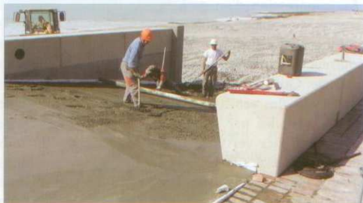
Des lattages en bois exotique n'ayant pu être posés avant la saison estivale sur tous les parvis, les équipes du chantier ont coulé des dalles et des descentes de béton provisoires. Reprise des travaux et des finitions à la mi-septembre. Quant au poste de secours, celui-ci sera repensé, sans doute en 2006...
