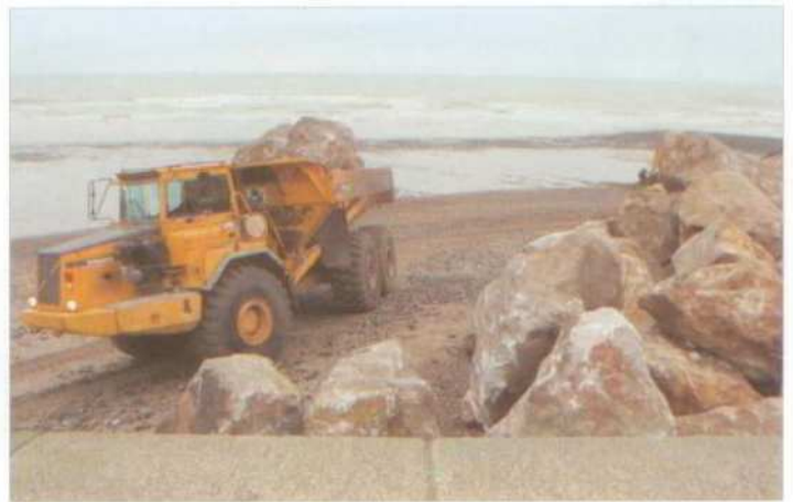
▲ D'autres convois arrivent : il faut étayer provisoirement l'accès au site, sinon les rotations vont fragiliser la descente aménagée...
