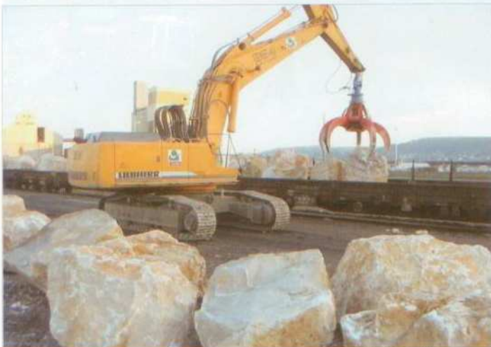
▲ Impressionnant : des convois de roches, de 5 à 7 tonnes chacune, arrivent par rail directement d'une carrière du Boulonnais et sont déchargés dans la foulée ...
