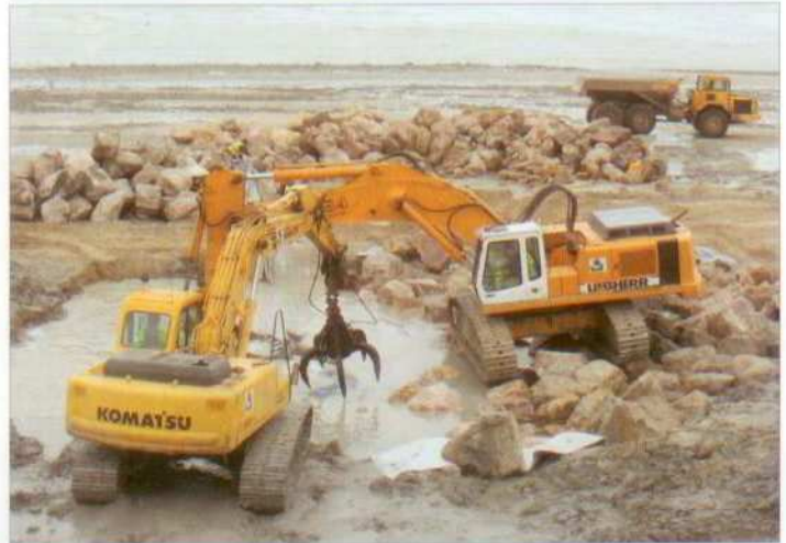
▲L'opération est délicate et sous l'eau on ne voit rien : la pelleteuse n'hésite pas, elle roule sur les roches pour aider la pose des bandes de feutre : il s'agit du futur pied du talus et l'engin en a vu d'autres...
