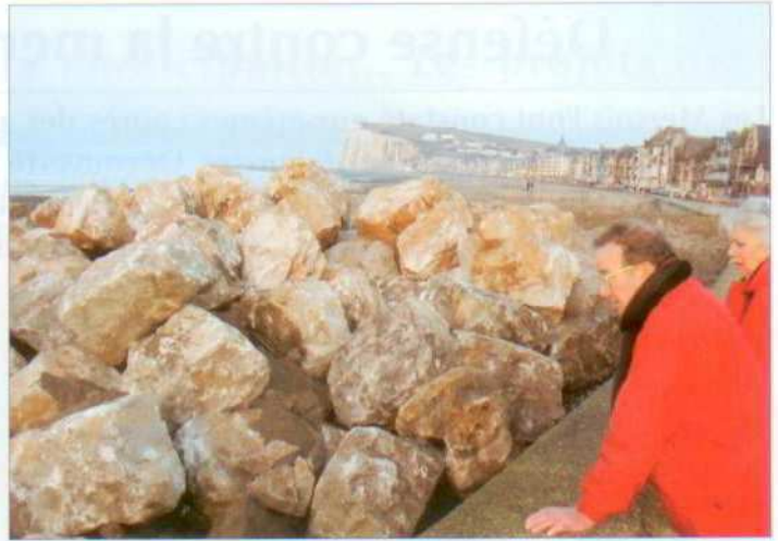
▲Les mersois commencent à voir s'empiler les enrochements, mais ce tas est provisoire, il faut d'abord s'occuper du pied du talus amortisseur. En attendant le site est entièrement clôturé pour raisons de sécurité. Des feux tricolores sont posés pour réguler la circulation...
