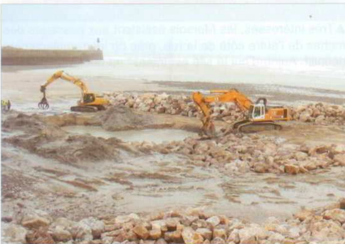
▲On a déjà, au 20 janvier, un aperçu de l'avancée du chantier. Au premier plan, des enrochements de taille réduite qui serviront de tout venant pour les couches intérieures du talus amortisseur. Il faut faire vite entre chaque marée, des projecteurs permettront bientôt de travailler de nuit...
