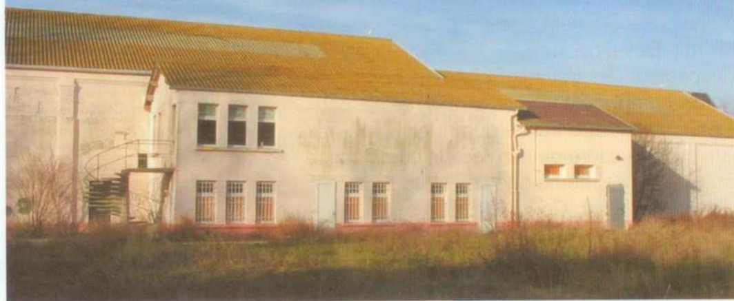
Vue extérieure du bâtiment...
