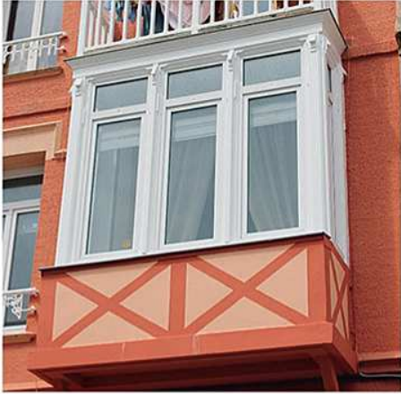
▲ 3 rue Maurice Dupont : réfection par une remise en peinture des ouvrants de ce Bow-Window, sur cette belle villa proche de l'esplanade...
