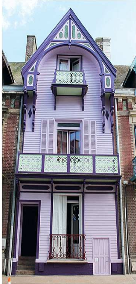
▲ 18 avenue du Maréchal Foch : ravalement de la façade, remise en peinture à l'identique selon les prescriptions de l'ABF en 2006, en deux tons de violet et un de vert clair. Une fort belle remise en peinture, rafraîchissante, pour cette magnifique villa...
