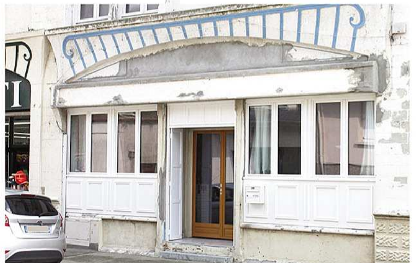
▲ RDC "Garage de la Plage" Avenue Foch : habillage des fenêtre ossature bois, changement de porte et retrait de volets roulants...
