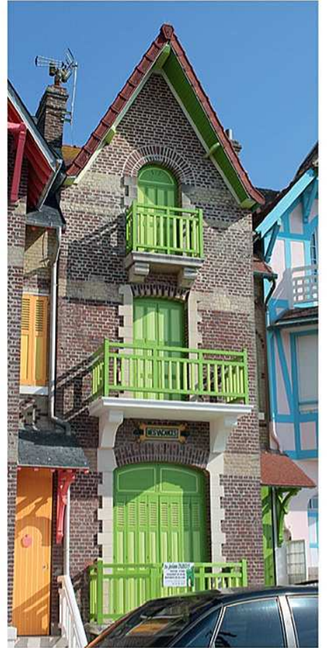
▲ Villa "Mes Vacances" Esplanade du Général Leclerc, côté Le Tréport. Superbe remise en peinture de cette belle villa qui, avec les couleurs de sa voisine "Pom' d'Api" et de celle d'à-côté, offre un tryptique de couleurs particulièrement sympathique...
