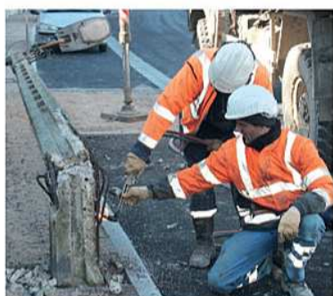
▲ Découpe au chalumeau des vieux poteaux.
