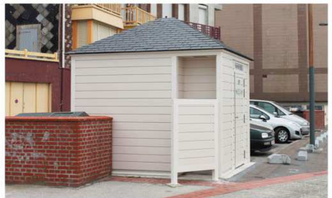
En mai, de nouvelles toilettes automatiques avec urinoir extérieur et paravent ont été posées en pied de falaise. Le petit chalet qui les abrite est le même que celui posé au sein du jardin d'enfants. Pratique, il s'intègre particulièrement bien dans le site...
