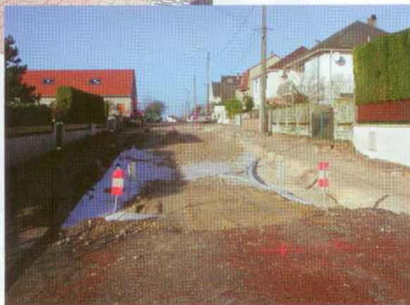
Avenue du panorama pendant les travaux
