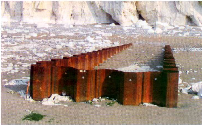
Fin Mars, les fondations en palplanches métalliques du futur l'épi n° 10 b sont déjà réalisées. A l'intérieur une couche de craie va être enlevée puis du béton coulé avant l'arrivée des modules de béton préfabriqués en fabrication sur le site de la Fée des Mers...
