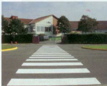
Réaménagement du stationnement et de la circulation des véhicules et des passages piétons à l'entrée du Collège Joliot Curie
