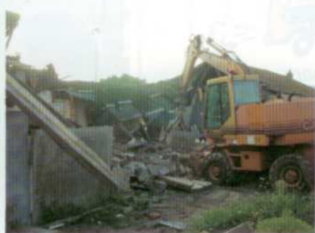
Démolition des anciens vestiaires du stade qui étaient interdits au public depuis 1994. (sept. 2002)
