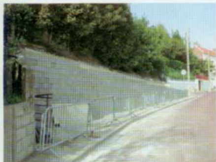
Mur de soutènement de la rue du Dr Roux (sept. 2002)
