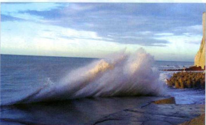
Disposés provisoirement au pied de la falaise, les tétrapodes ne jouent plus leur rôle de barrière contre la houle. Au moindre coup de vent la mer reprend ses droits et vient se briser contre la descente en béton qui mène sur l'estran...
