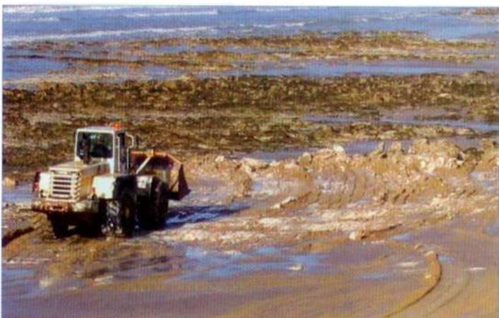
Toujours pour sécuriser l'arrivée des bateaux, (des barges à fond plat spécialisées pour le clapage maritime), une autre pelleuse "racle" une partie des rochers de craie de l'estran afin de les mettre à niveau. Quelques heures suffiront pour cette opération...
