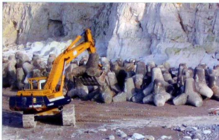
Pour sécuriser les bateaux qui vont livrer les enrochements en direct de Boulogne sur Mer, une pelleuse s'est attaquée à la barre de tétrapodes. En deux jours les modules de béton de 1963 ont gagné le pied de falaise, ils seront réutilisés...
