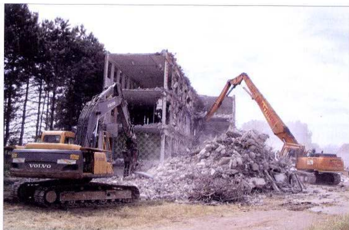
Les bâtiments de l'ancienne colonie de vacances SNCF ont été rasés à la mi-juin...
