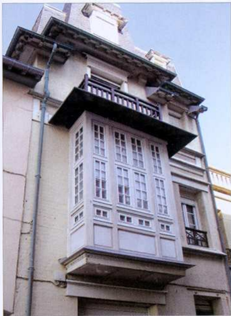
Détruit en totalité ou presque lors d'une tempête, le bow-window de la villa de M. Gelon, rue Duquesne, vient lui aussi d'être parfaitement remis en état...
