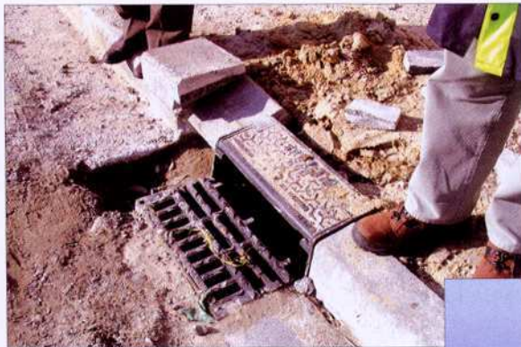
De nouvelles "bouches avaloirs" placées à intervalles réguliers vont piéger l'eau sur toute la longueur de la rue...
