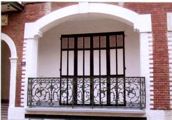
▼Ici une superbe loggia rue Raspail...
