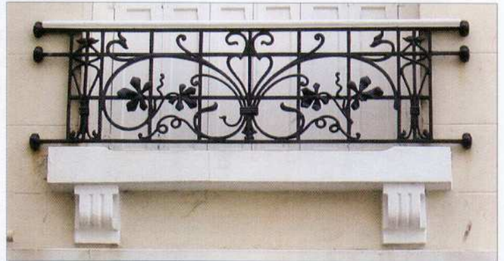
▲ Les balcons sont le fruit d'un travail d'ornementation souvent compliqué. La corrosion est surtout retardée quand le métal est de bonne qualité et l'entretien régulier...
