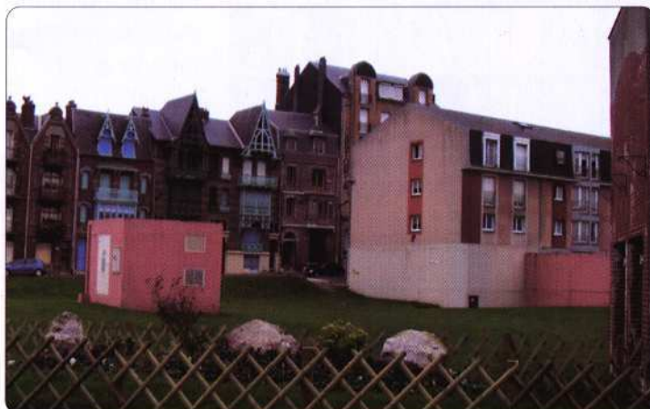
Le site Casino, son "cube" central et ses piliers inachevés attendent depuis 15 ans qu'une fin heureuse soit trouvée au projet initial. Cette résidence est assurément un beau projet pour Mers.
