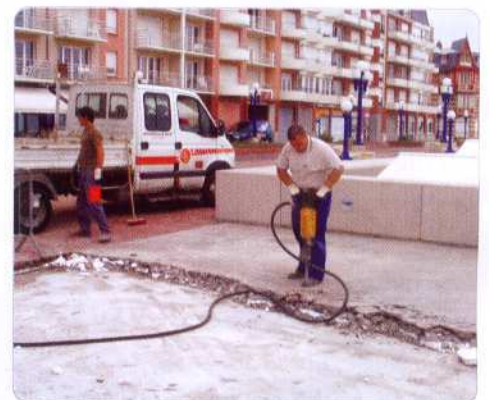
Les finitions du chantier débutent. 50 000 m 3 de galets repousseront bientôt la mer bien plus loin qu'actuellement, ce qui sera précieux lors des fortes tempêtes...
