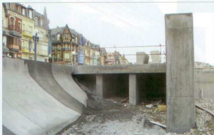
Certains parvis ont nécessité d'être particulièrement étayés. Effectivement l'ouvrage devrait être solide !
