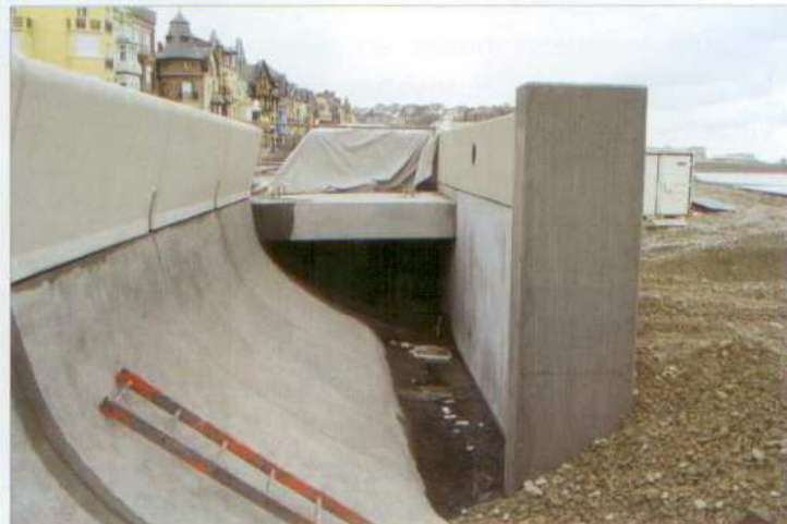
A mi-chemin entre les épis, de petits parvis d'accès aux galets permettent de réduire de moitié la distance et d'accéder à la plage en toute facilité. Des escaliers vont être posés...
