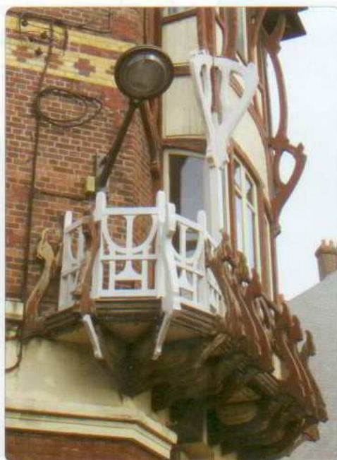
La villa La Française vient de faire l'objet d'une remise en état de ses boiseries. Elle va être bientôt entièrement repeinte, donnant un nouveau cachet à cette intersection de l'avenue du Maréchal Foch...
