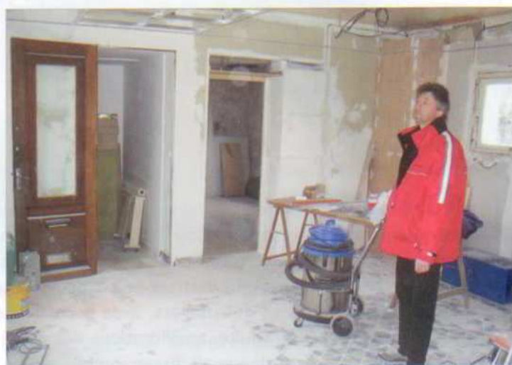
Le chantier du rez-de-chaussée des bureaux. L'accueil y sera installé, ainsi que les bureaux des adjoints au responsable. Hervé Duplessis occupera le bureau du fond...
