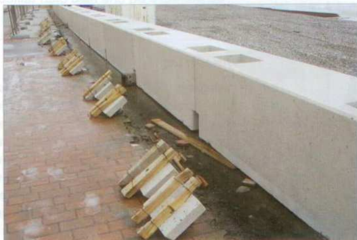
Après la pose et le scellement de fers à béton dans les cavités, du béton est coulé puis les "couvercles" seront scellés...
