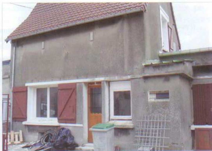
Les nouveaux bureaux sont placés à l'entrée des ateliers municipaux, ici en cours de travaux. La façade sera repeinte afin d'offrir un abord visuel plus agréable...
