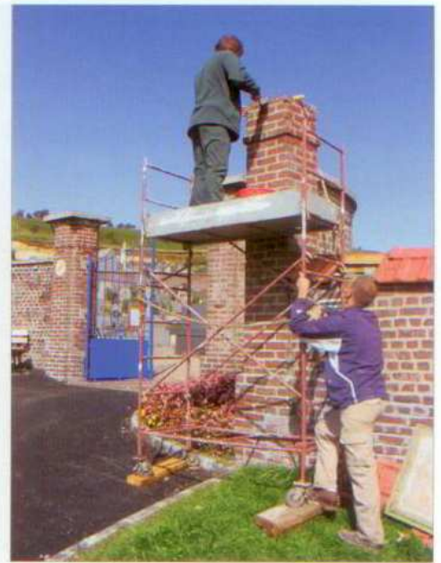
Ici l'équipe consolide un pilier d'une des entrées du cimetière...
